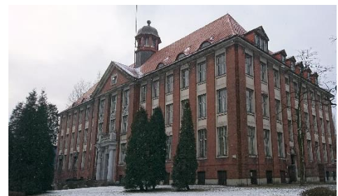
Fig. 1. The view of Alchemia S.A. Oddział Walcownia Rur Batory in Chorzów
