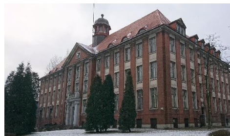
Fig. 1. The view of Alchemia S.A. Oddział Walcownia Rur Batory in Chorzów
