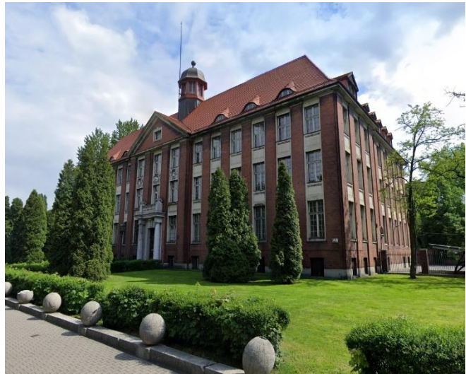
Fig. 1. The view of Alchemia S.A. Oddział Walcownia Rur Batory in Chorzów
